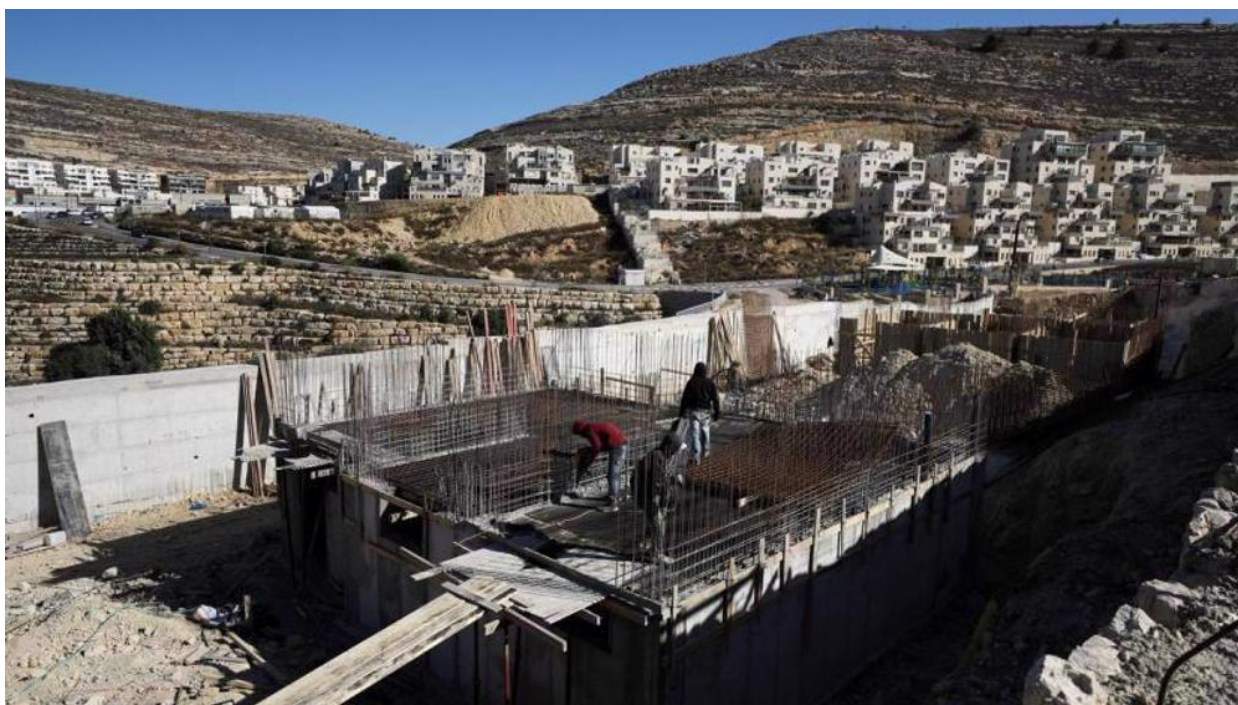
Рисунок 2 – Пример использования монолитной железобетонной конструкции в строительстве
