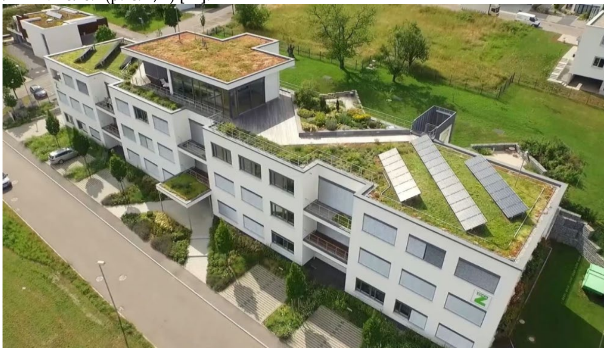
Рисунок 1 – Зеленые крыши в г. Штутгарт
