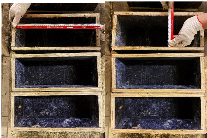
Рисунок 2. Опалубка из ламинированной фанеры (Коваленко А.А. 02.03.22)
