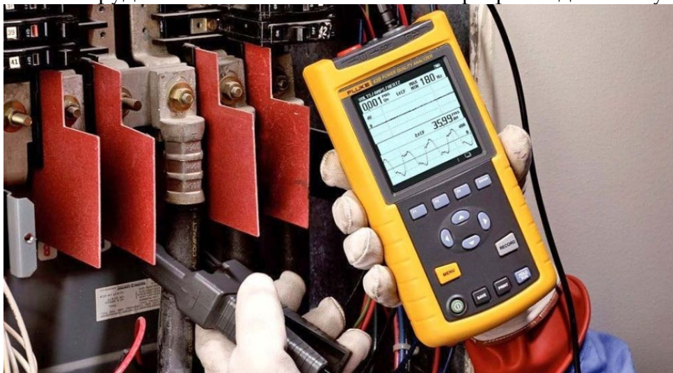
Рисунок 2 – Анализатор качества электроэнергии Fluke 43B [8].
