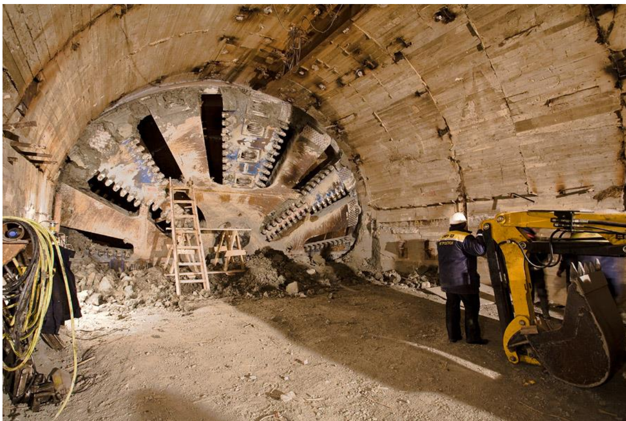
Рисунок 2 – Закрытый способ сооружения тоннеля
