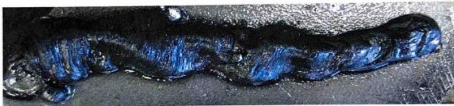
Рисунок 11 – Выделившийся после сварки шлак на поверхности сварного шва, выполненного электродами марки ЭПС-АН1
